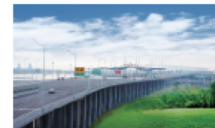
● 青岛跨海大桥
