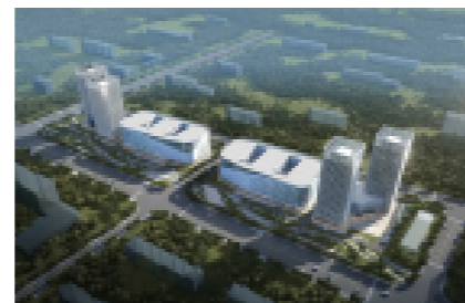
● 济南闵鲁物流产业园
